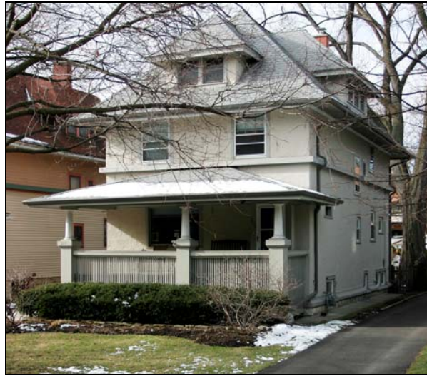
305 N. Grove Avenue
